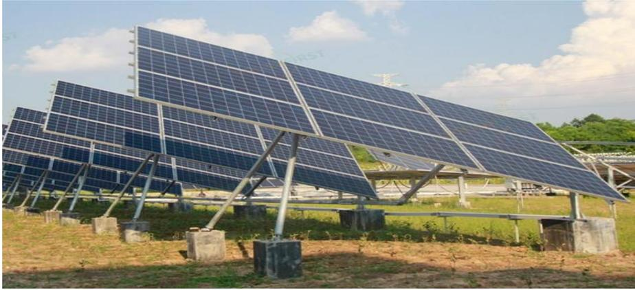
**La figure II.8 :** *Suiveur à axe vertical incliné.*
