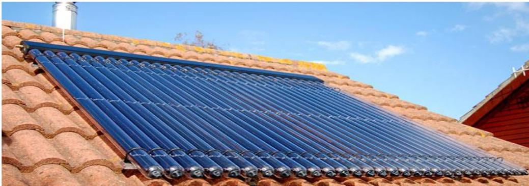
**Figure I.12** : Un capteur solaire thermique.
