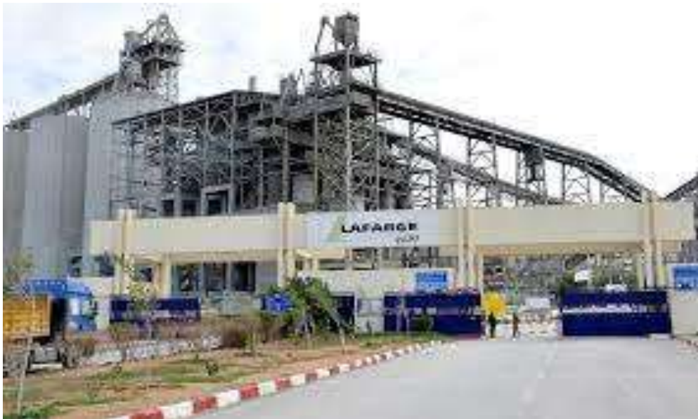
Figure 0.1 : L'entreprise Lafarge Holcim Ciment Oggaz [1].
