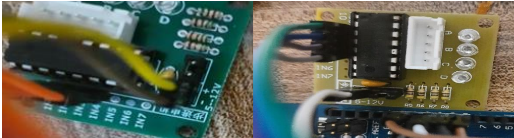
Figure39 : L'alimentation des deux drivers
