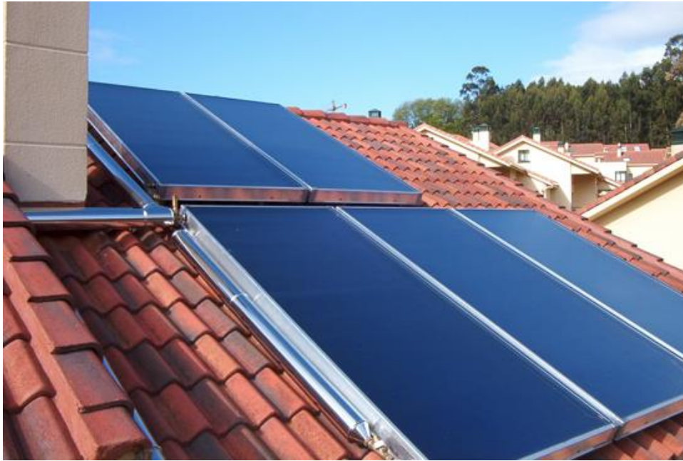
Figure I-6 Capteur solaire non concentrés ou stationnaires.
