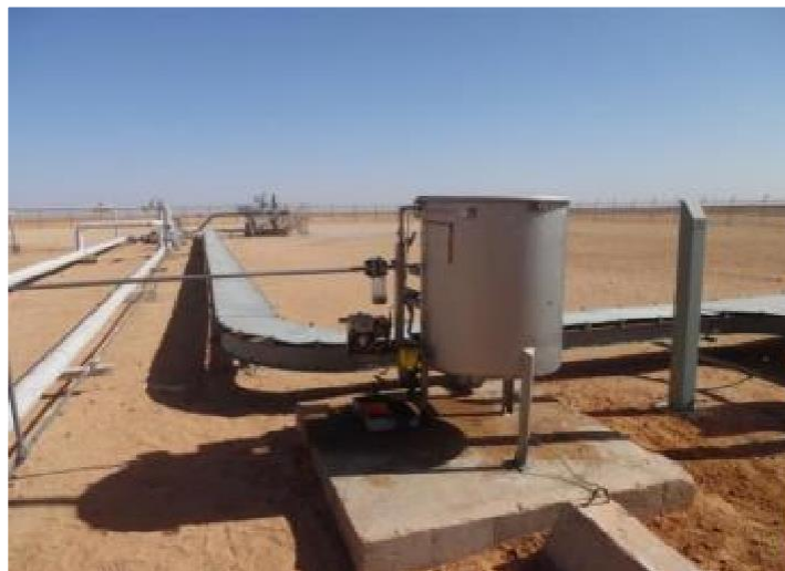
Figure 1-24 Système d'injection d'inhibiteur de corrosion
