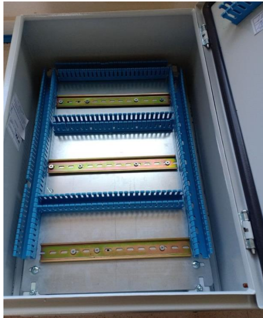
Figure 3.10 : Fixation les rails et les goulottes
