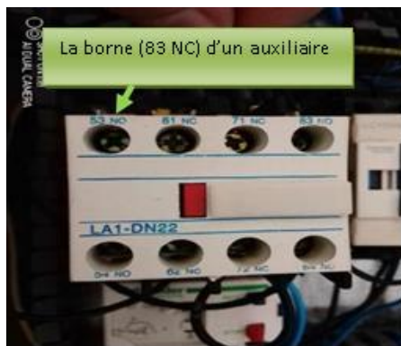
Figure 3.27 : Raccordement entre lampe verte et contact auxiliaire
