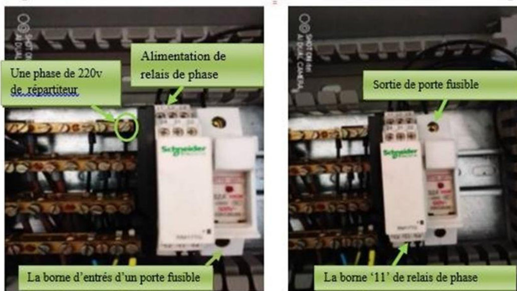
Figure 3.21 : Le branchement de relais phase et de porte fusible
