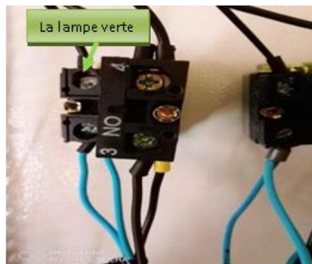
Figure 3.27 : Raccordement entre lampe verte et contact auxiliaire
