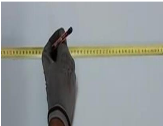
Figure 3.11: Traçage la face d'avant d'une armoire électrique
