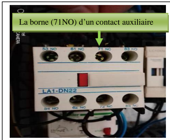
Figure 3.26 : Raccordement entre lampe rouge et contact auxiliaire
