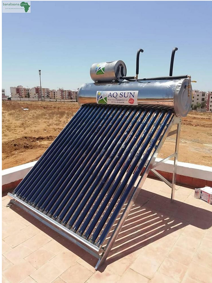
Figure 5 - Chauffe-eau solaire à tubes sous vide
