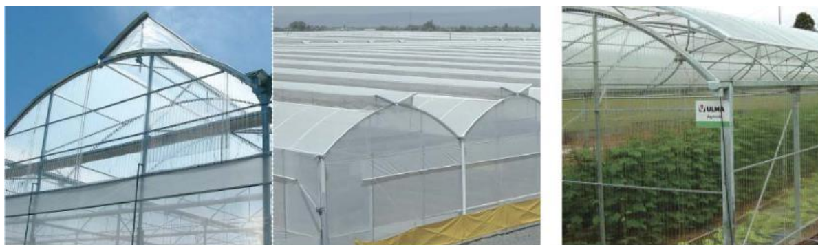
Figure I. 4: Aération faîtage
