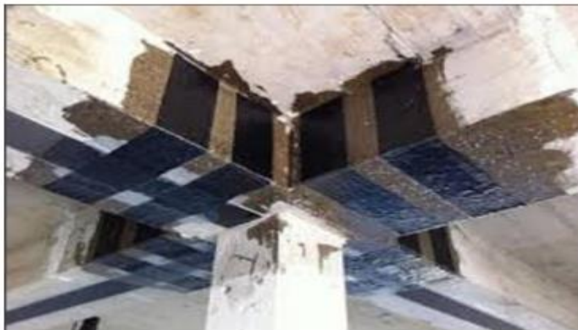
Figure I.5 : Renforcement des poutres par matériaux composites.
