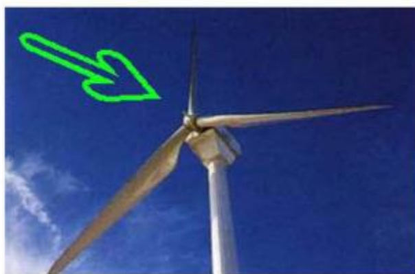
Figure 1.11 Eolienne face au vent avec pylône cylindrique de grande section.
