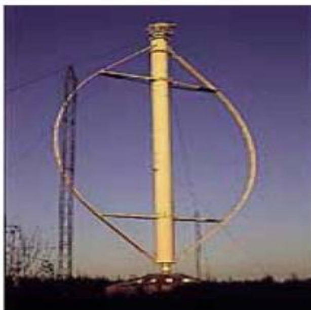
Figure 1.5 Eolienne de Darrieus de 4.200 kW et 100 m de diamètre.
