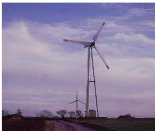
Figure 1.10 Eolienne de marque BONUS de 95kltV avec tour à trois pieds [2].
