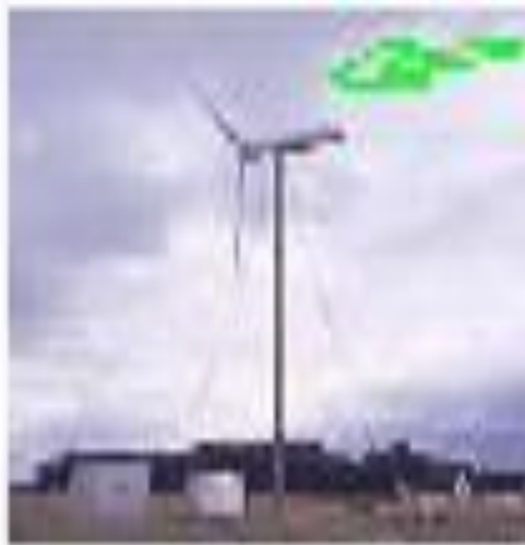
Figure 1.9 Petite éolienne sous le vent de 22kltV avec pylône léger haubané [2].
