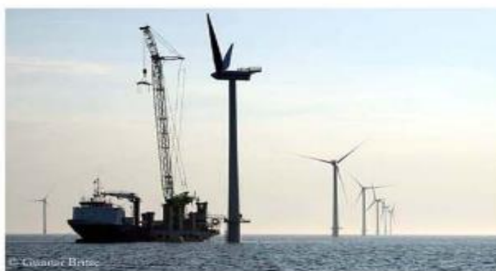
Figure 1.3 Installation d'éoliennes offshore en Mer du Nord (Photo Gunnar Britse).
