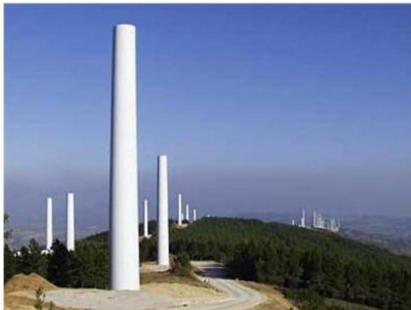
Figure 1.7 Pylône tubulaire d'un futur parc éolien [2].
