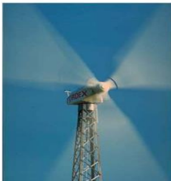
Figure 1.8 Eolienne avec pylône en treillis [2].
