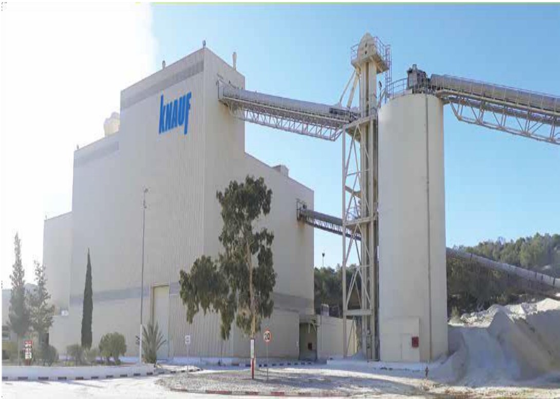
Figure I.1: L'usine KNAUF (coté usine poudre) Algérie Oran
