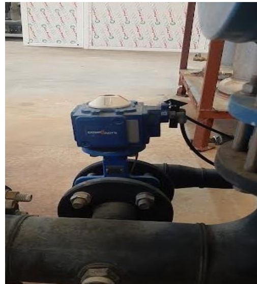
Figure 10 : les vannes (actionneurs) ont commandé pneumatique
