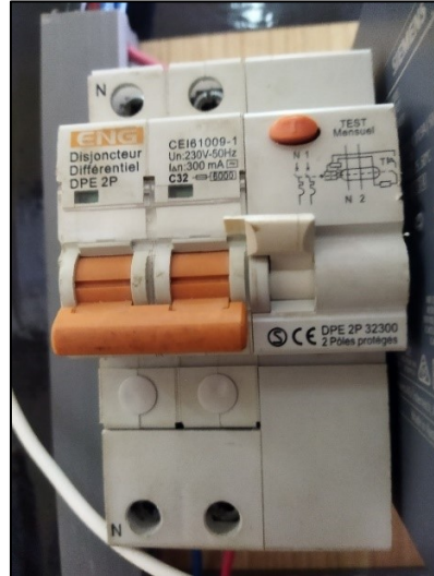
Figure 52. Disjoncteur différentiel DPE 2P.
