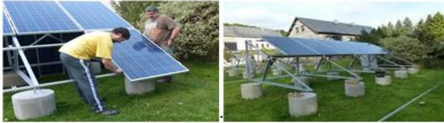
**Figure 2.2:**repeent le montage des supports de ces modules
