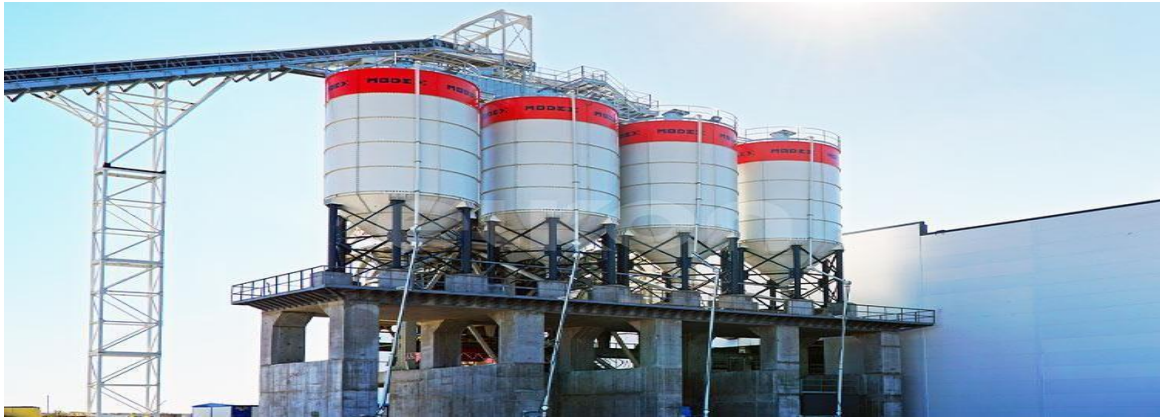
Figure 4 : Centrale à béton à tour (Verticale).
