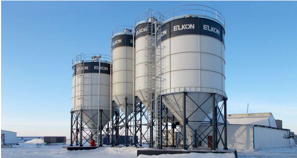
Figure 8 : Silos à ciment.
