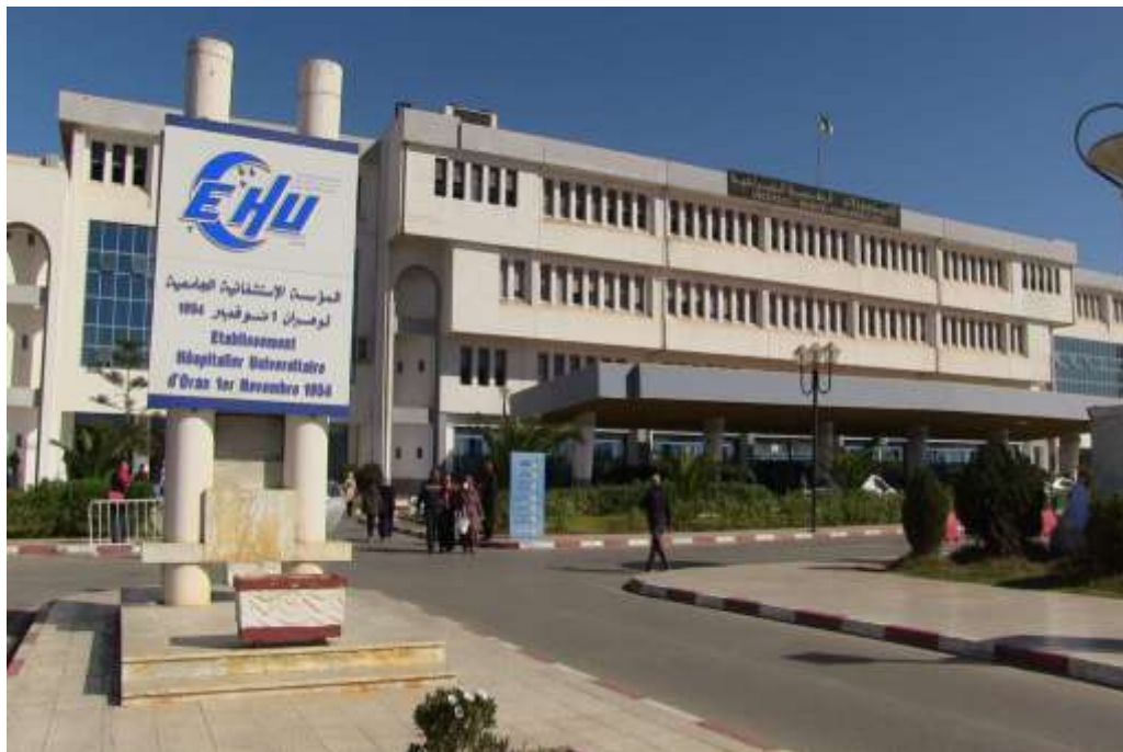
Figure II.1 : Vue générale de l'EHU d'Oran
