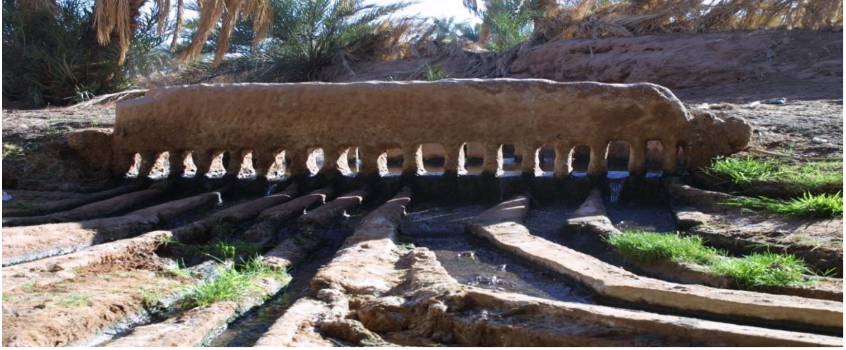
الصورة رقم (05) : تمثل القسرية لتوزيع مياه الفقارة بتيطاف (إعداد إيدر يوسف )
