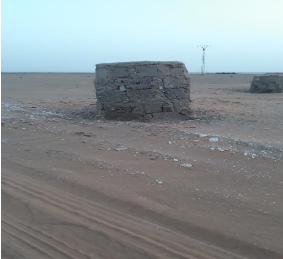
صورة رقم (03) ملتقطة لأبار التهوية والصيانة لفقارة أو لاد مالك لقصر تيطاف سنة 2019 (إيدر يوسف)
