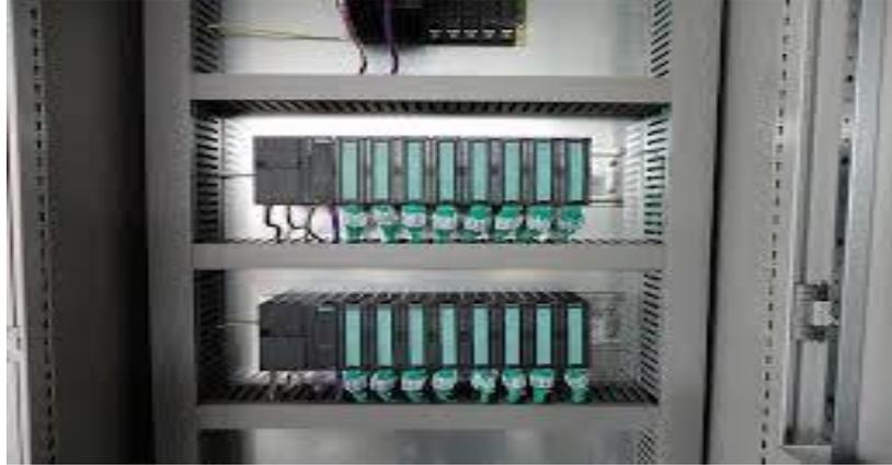
Figure II.2: Exemple d'une armoire d'Api (logique programmée)
