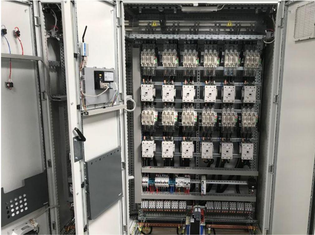
Figure II.1: Exemple d'une armoire électrique
