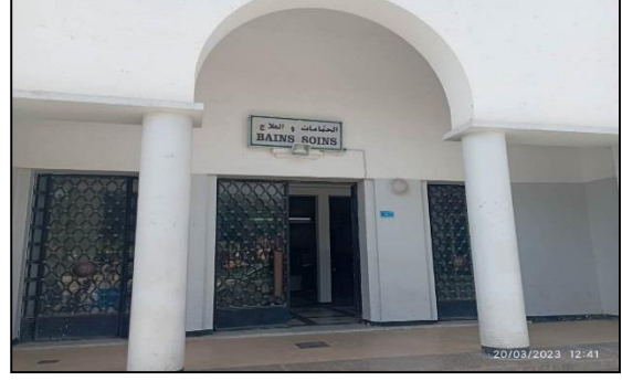
صورة 24: واجهة المحطة المعدنية
