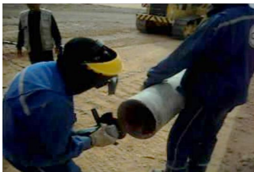
Figure 2 .3 Chenfreinage d'un joint
