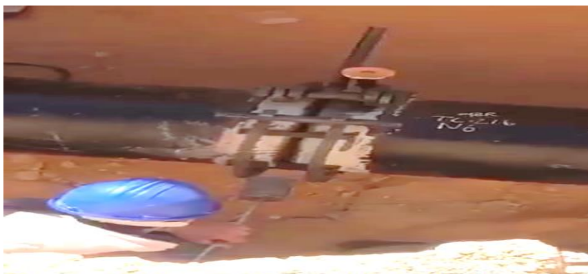
Figure 2 .5 Préchauffage avant le soudage
