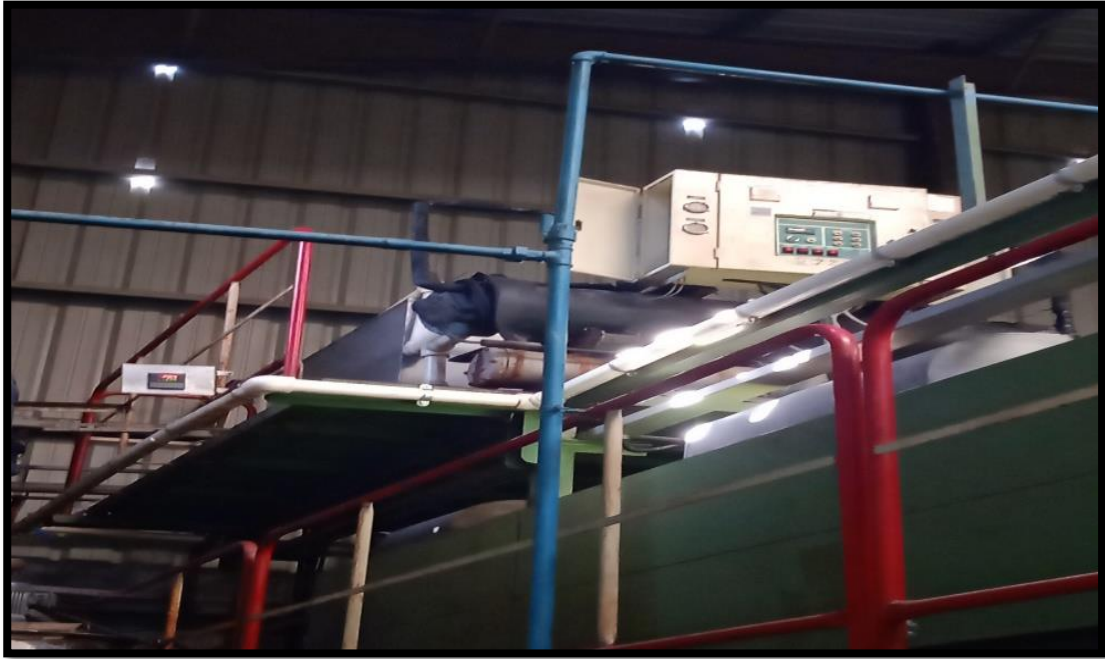
Figure III-1: pompe bache à eau
