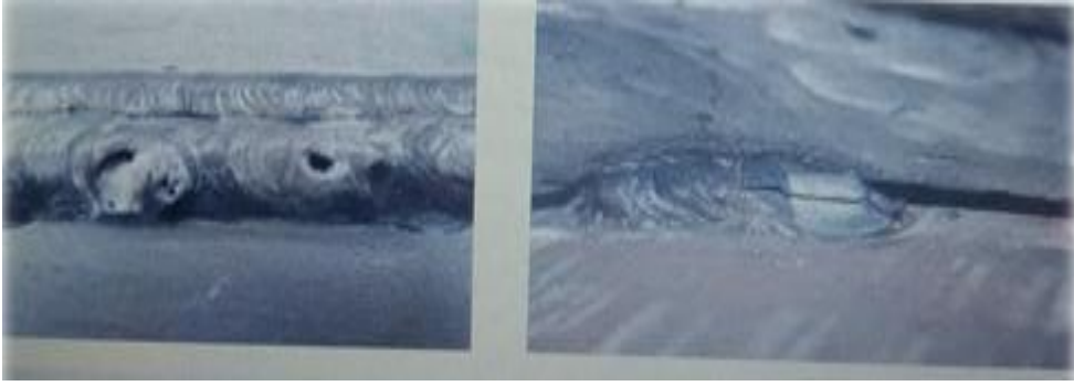
Figure 11 : défauts de moulage.
