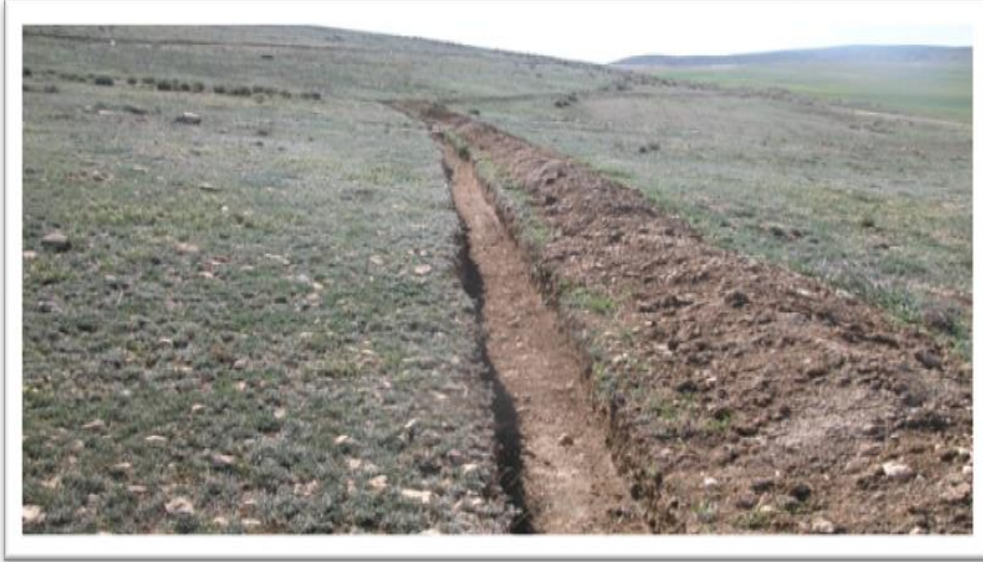
الصورة رقم (48): استعمال الخنادق ببلدية تعظمت ولاية الجلفة HCDS 2016
