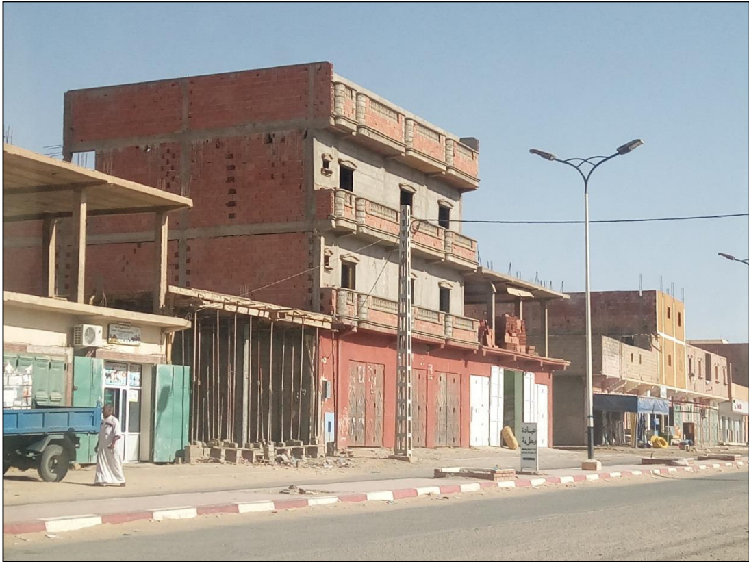
صورة رقم 7: توضح وضعية بناية من حيث عدد الطوابق، وضعية البناية الغير مكتملة، الواجهة، بحي المغيلي - 2017
