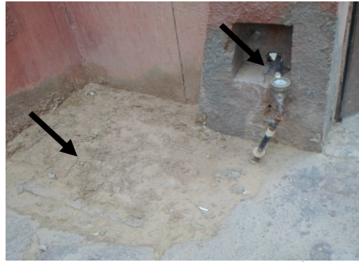
ربط لشبكة المياه بالقرب من الصرف الصحي
