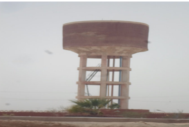
صورة 22: توضح خزان طريق المطار 1000 م 3
