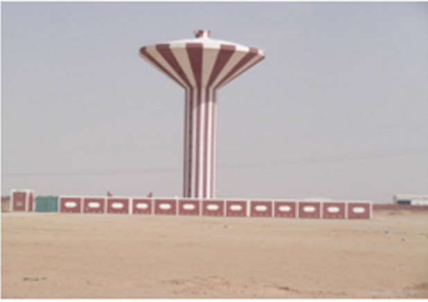
صورة 20: توضح خزان طريق بشار 1000 م 3
