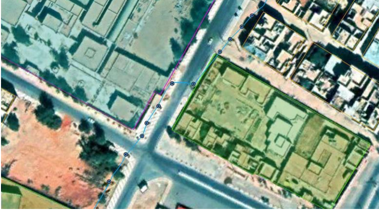
المصدر: قوقل إرث بتاريخ 2020/02/29 الصورة 23: وضعية فقارة أمراد قبل أشغال الصيانة عند تقاطعها مع الطريق وتغيير مسارها من الرصيف إلى رصيف آخر
