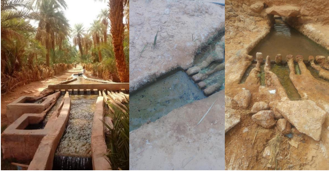
المصدر: مرصد الفقارة الصور رقم 7، 8 و9: "قسرية" حوض صغير على شكل مشط لتقسيم حصص الماء
