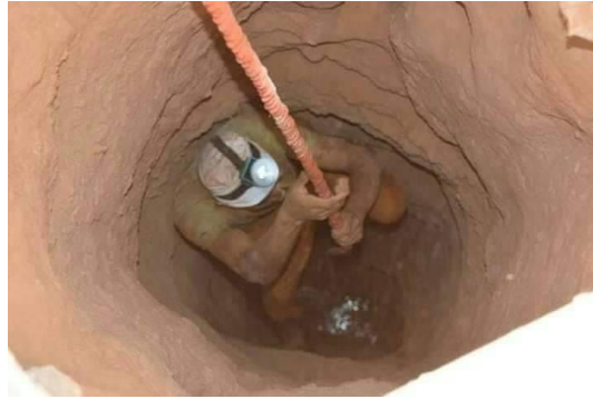
المصدر: مرصد الفقارة الصورة 3: آبار التهوية والصيانة
