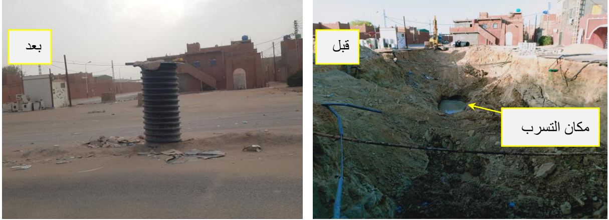
المصدر: مديرية الموارد المائية + بن زيطة عبدالقادر عزيزي يوسف الصورة 21 و22: تسرب المياه القذرة إلى الفقارة جراء عملية صيانة ودعم الفقارة
