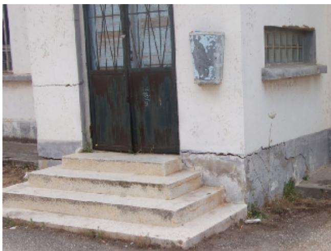
Photo : fissuration et basculement du bloc25 à l'intérieur de l'université Sénia 06/2013
