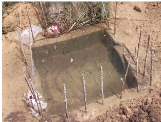
Photo : l'interruption des travaux par la remonté des eaux 06/2013
