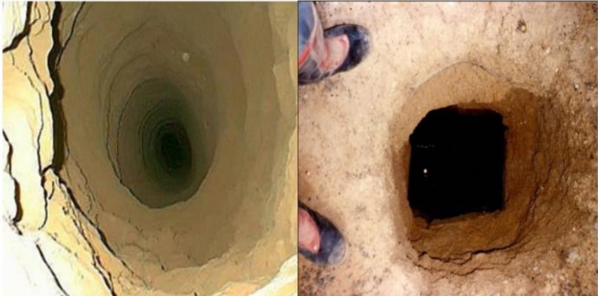
الصورة (01) و (02): المظهر الداخلي لبئر الفقارة لبئر من آبار المنبع المصدر: بكري، رفاقي
