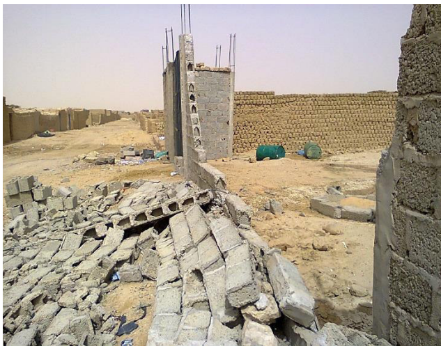
الصورة (63): سقوط جدار حديث البناء بسبب زوبعة
