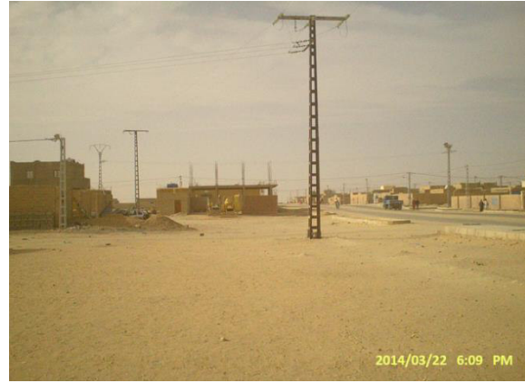
الصورة (56): فراغ بسبب أعمدة كهربائية (لنصاري -مارس 2014)
