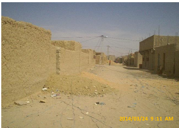
الصورة (65): إنتشار الاسلاك الكهربائية في الشوارع (لنصاري - مارس 2014)
