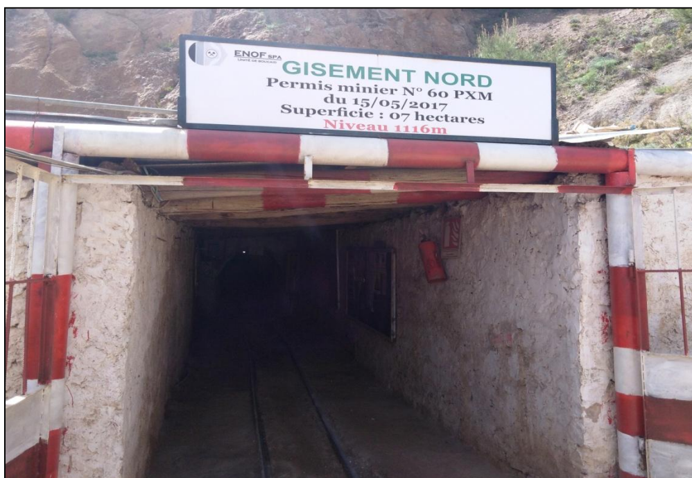
Photo 21: L'entrée du niveau d'exploitation 1116m-Gisement NORD-.
