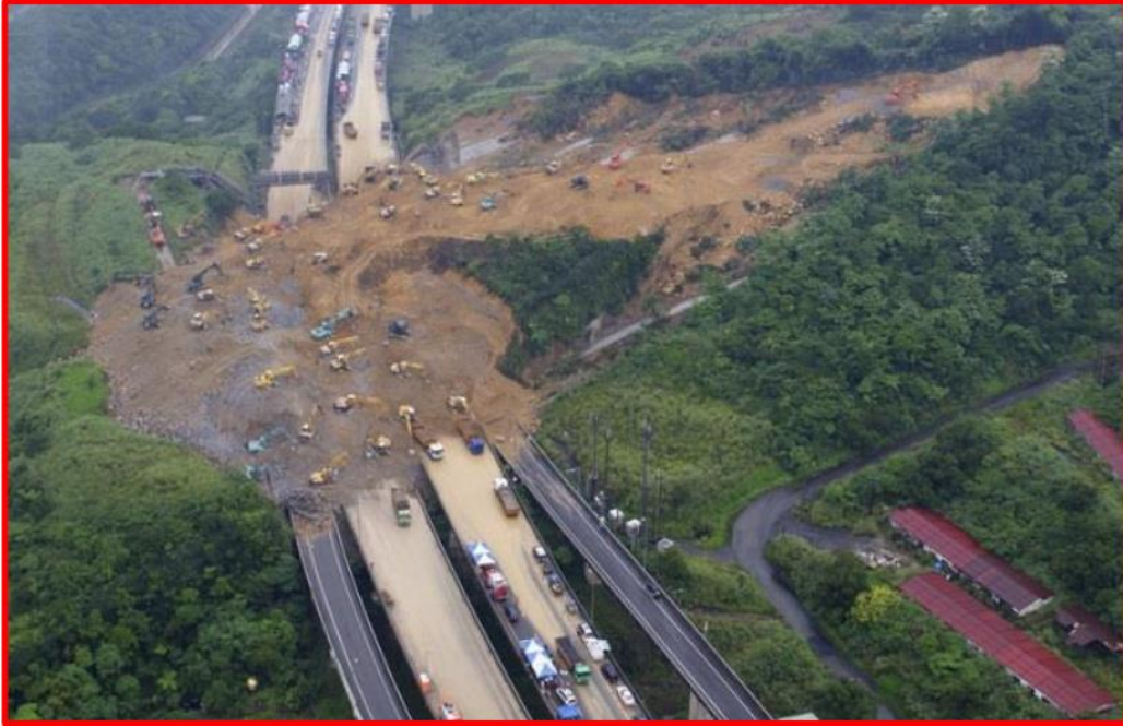
Figure 15 : Coulée boueuse, Autoroute de Taïwan 2010, in ( Achour 2017).
