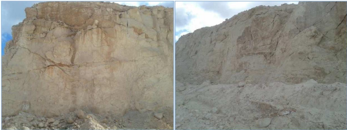
Fig.10: Réseau de fracture (A)
