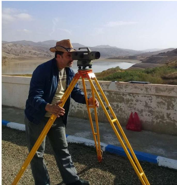
**Figure I.12:** Auscultation topographique d'un barrage (*opération de nivellement de précision*).
