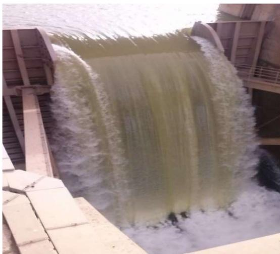
Figure I.13: Essai de fonctionnement d'un clapet de l'évacuateur du barrage de Cheliff Lot-1, Mostaganem.
