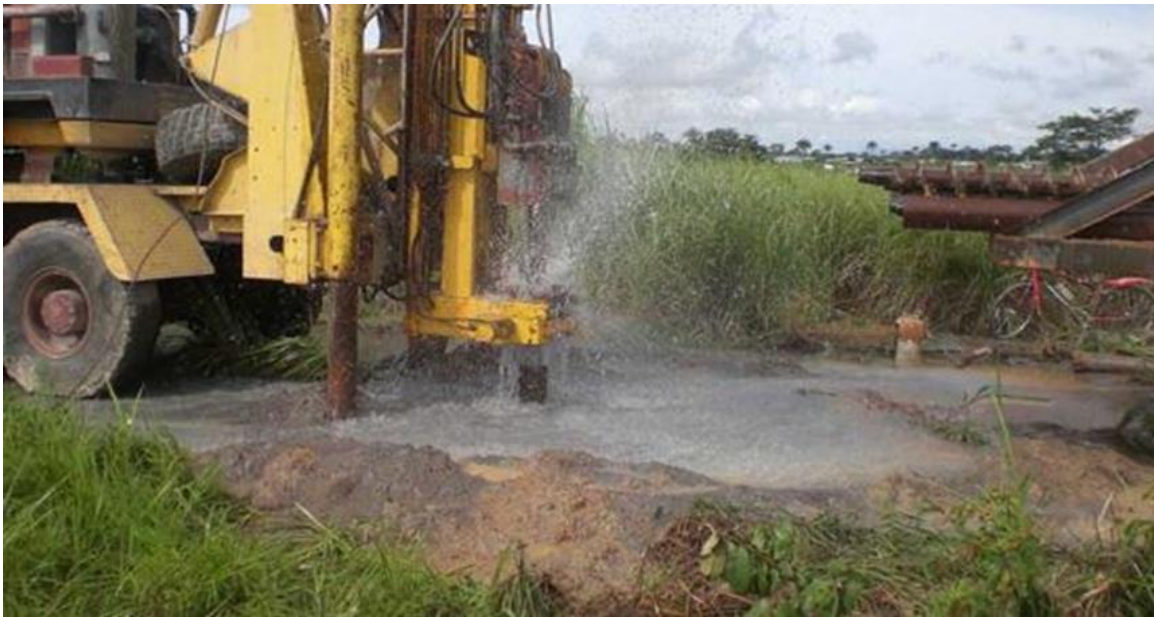
Figure n°02 : Réalisation d'un forage avec une Rotary pour la mobilisation de l'eau (PrixPose, 2018)
