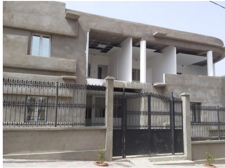
Photo 5 :équipement nouvellement créé
