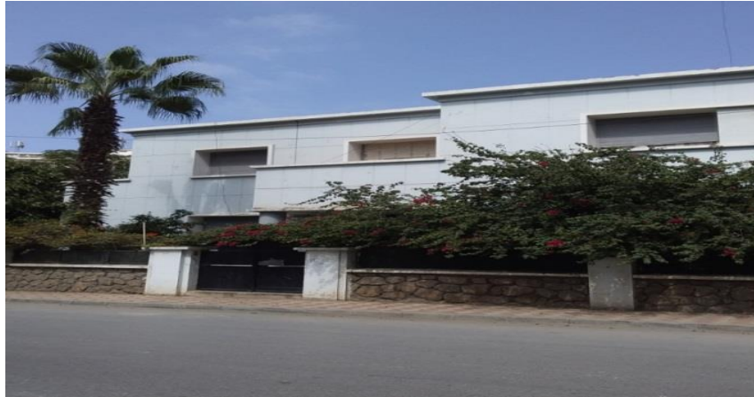
Photo 1 : Habitat individuel –maison de maitre (saint Charles)
