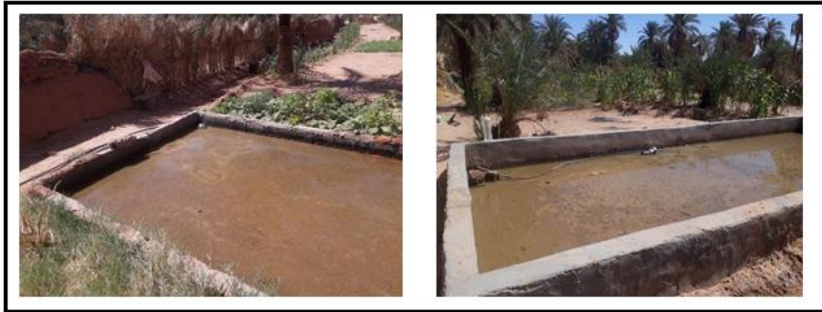
Figure N° 31 : Canal secondaire d'alimentation du bassin réception (madjane)
