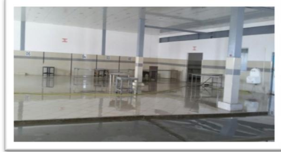
Photo N° 64 : zone technique pour le lavage des caisses alimentée en eau potable.
