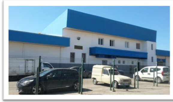
Photo N° 62: la halle à marée
