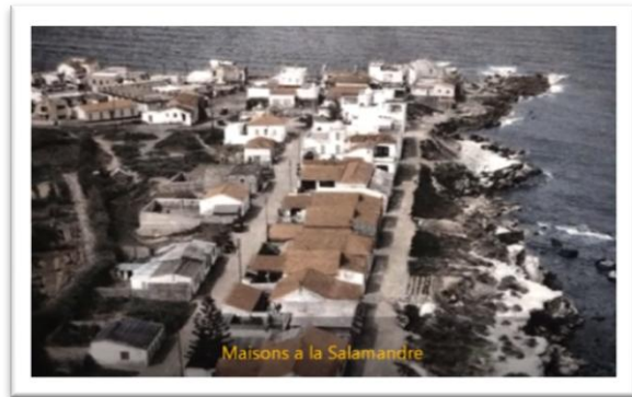
Photo N°21 : les maisons des falaises.
