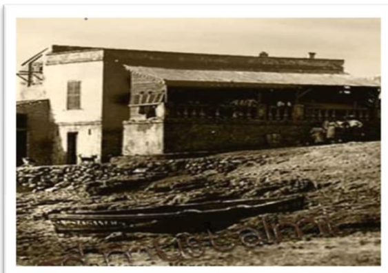
Photo N°5 : Le restaurant des roches avant De modification.
