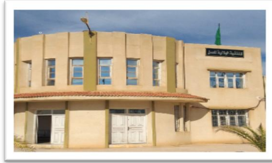
Photo N° 38 : Inspection nationale de Travaux.
