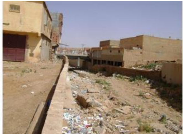
Photo 5 : Pont Grabba, rétrécissement de section
