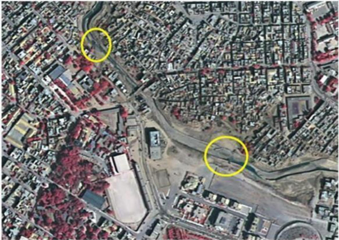
Figure 24 : Impacts de l'inondation identifiés sur les images du satellite Kompsat (©KARI), matérialisés par la destruction de deux passerelles (cercle en jaune).
