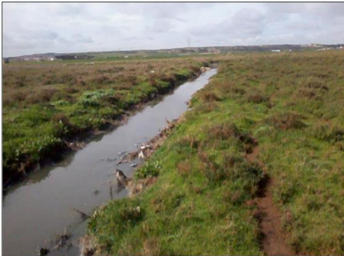
Photo. 02 : Canal de réseau d'assainissement (HassiAmeur vers le lac de Télamine). Sardou M, 2012
