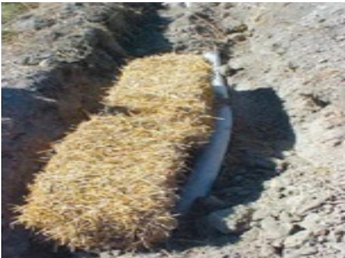
Figure n° 14 : Tranchées filtrantes
