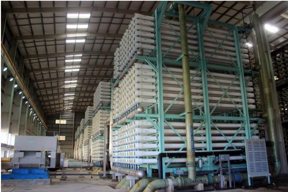
Figure N°15: étape de l'osmose inverse
