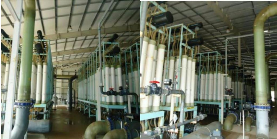
Figure N°13 : étape de l'ultrafiltration
