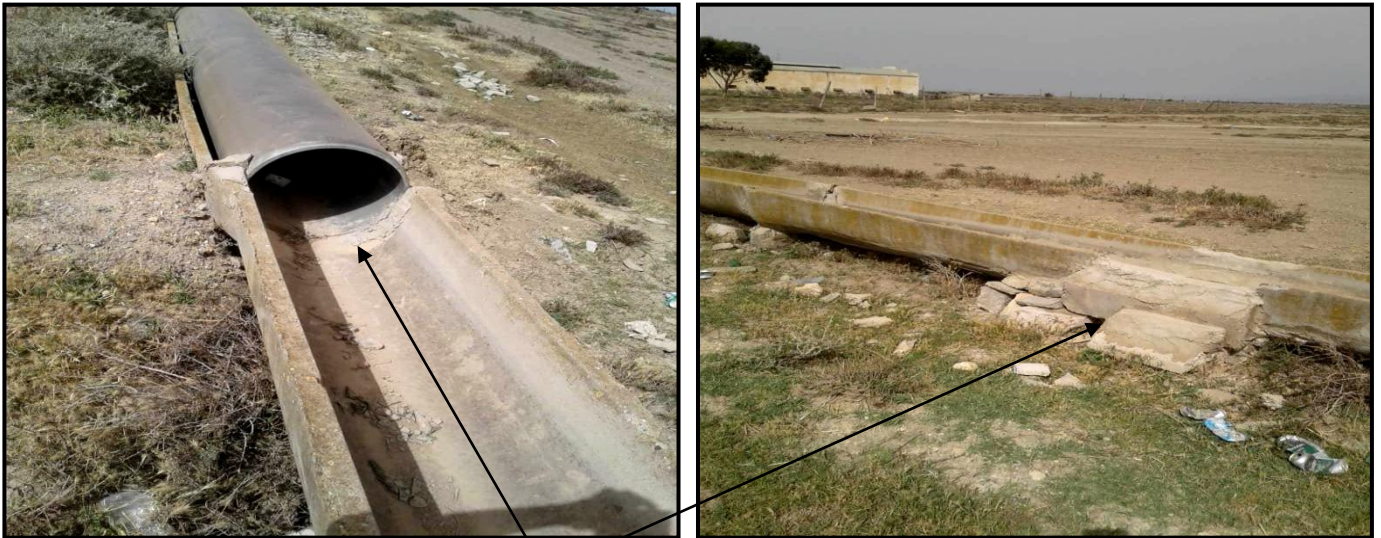
Reconstitution d'un canal tertiaire à partir d'éléments de récupération « Tuyau en plastique ou bien bloc en béton (Cliché BENSELIM, juin 2018)
