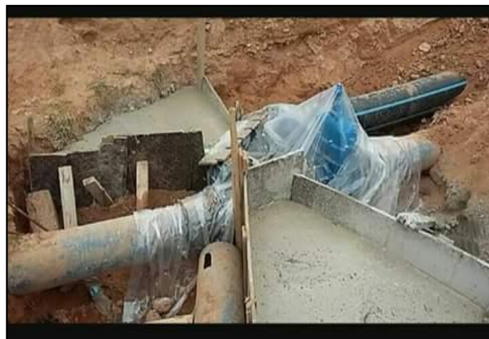
Photo.15: Canal d'irrigation enterré avec une pompe d'eau (Source : Google)
