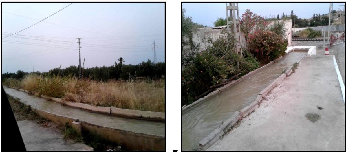
Photo.6 : commune d'Oggaz (région Nord – Ouest de Sig, canal à ciel ouvert rempli d'eau (Cliché BENSELIM, juin 2018)
