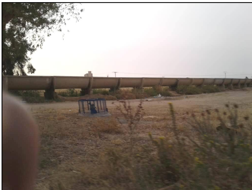
Photo.17 : canal d'eau à ciel ouvert / parallèlement une pompe d'eau d'une canalisation enterrée (Cliché BENSELIM, juin 2018)
