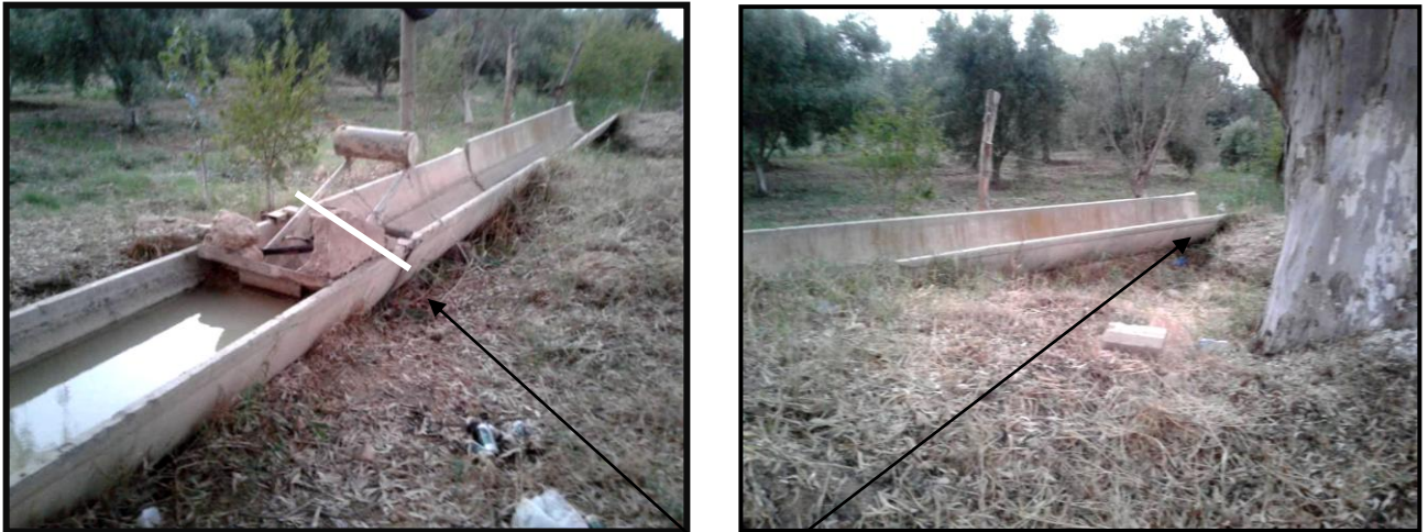
Photo.9 : commune de Sig (région Nord), canal détruit rempli d'eau stagnée (Cliché BENSELIM, juin 2018)
