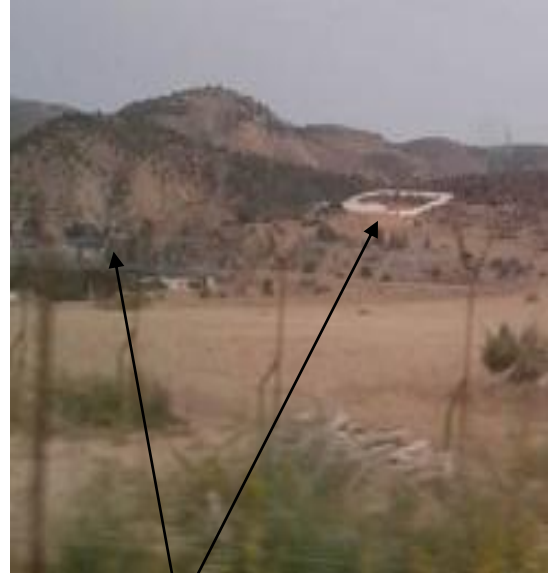
Photo .5 : le petit barrage de Sig « barrage de régularisation avec château d'eau » (Cliché BENSELIM, juin 2018)
