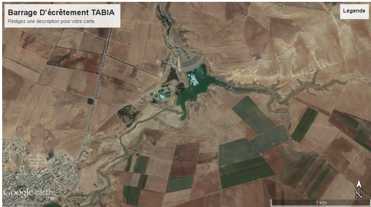
BARRAGE D'ECRETEMENT TABIA
