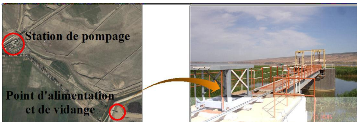
Figure 21 : Point d'alimentation par pompage du lac
