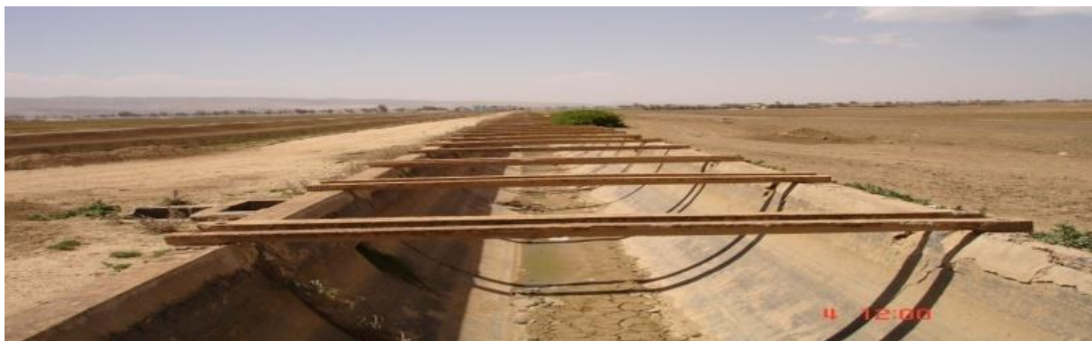
Figure 22 : Canal Tronc Commun (S .B 2013)
