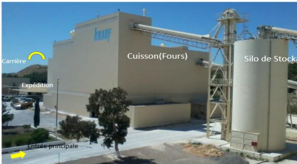
Figure9: une partie de l'usine de plâtre Knauf
