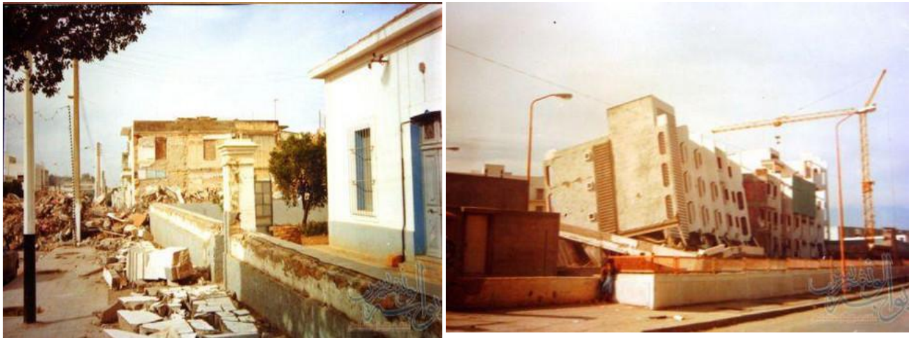
Figure 15: Séisme Orléansville 09-09-1954 (CRAAG)
