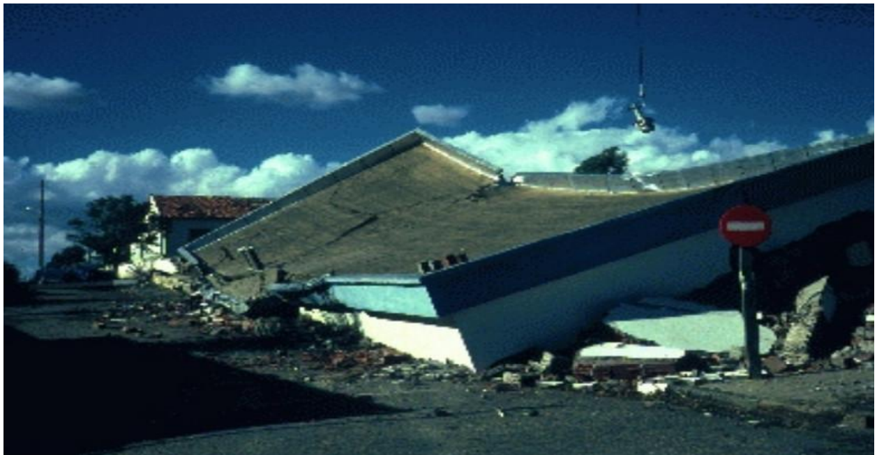
Figure 22 : Le séisme d'El Asnam 10 octobre 1980 (Ms 7.3 ) (CRAAG)
