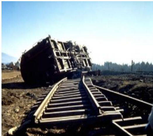
Figure 25 : Effet du séisme d'El Asnam 10.10.1980 sur le Chemin de fer (CRAAG).
