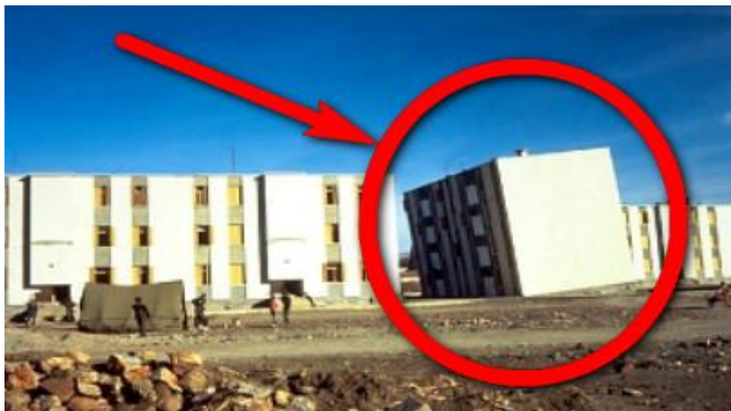
Figure 23 : Effet du séisme d'El Asnam 10.10.1980 sur le bâti (CRAAG)
