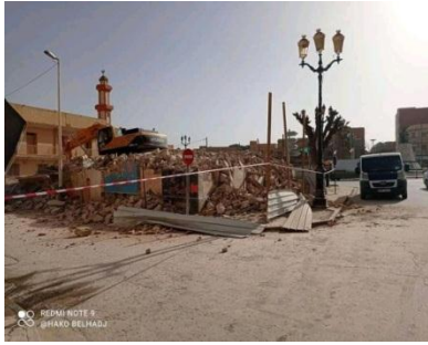
صورة رقم 28: هدم المبنى
