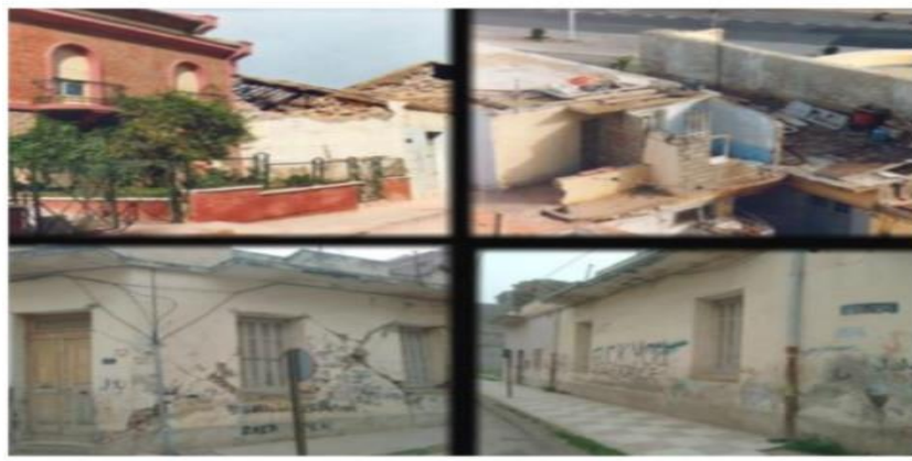
Photo 1 : Maisons au niveau du Faubourg détruites 1 er novembre.
