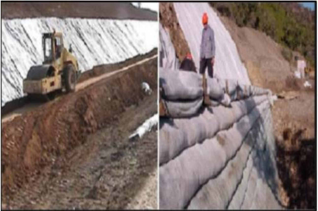
Fig.45 : Le renforcement du talus en utilisant du géotextile.
