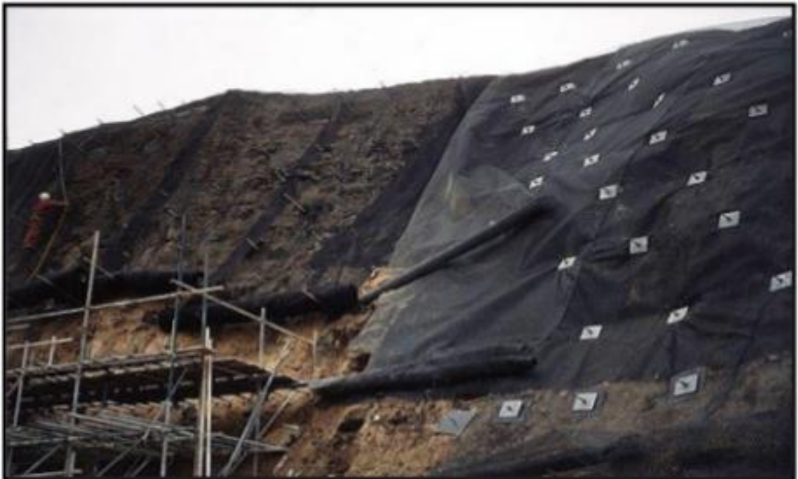
Fig.44 : Un versant stabilisé par clouage.
